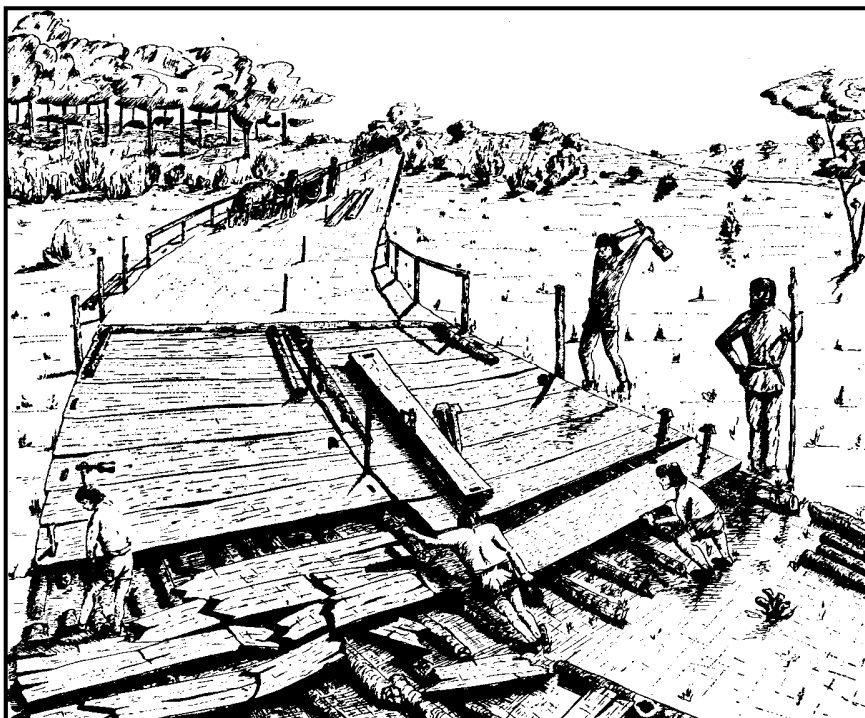
Abbildung 6: Rekonstruktionsbild: Bau des Bohlenweges über das Sukower Moor (aus J. Herrmann, 1976)
